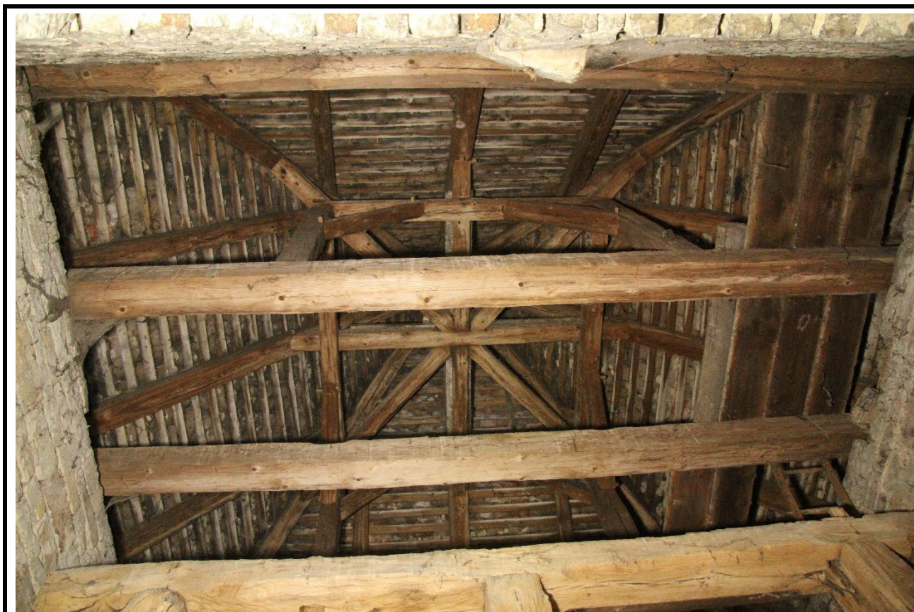
Krov věže v pohledu z 3. patra věže. Foto: Jaroslav Skopec, 2018.
