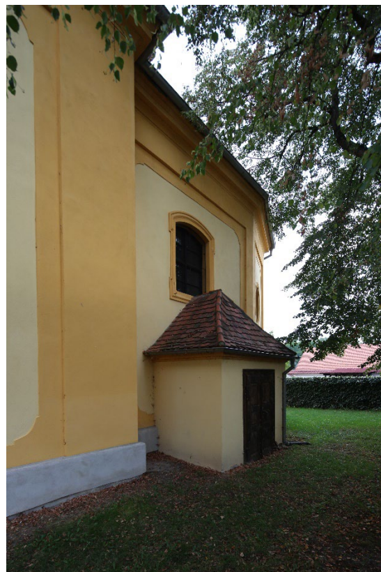
Presbytář s jižním přístavkem v pohledu od jihozápadu. Foto: Marta Pavlíková, 2018.
