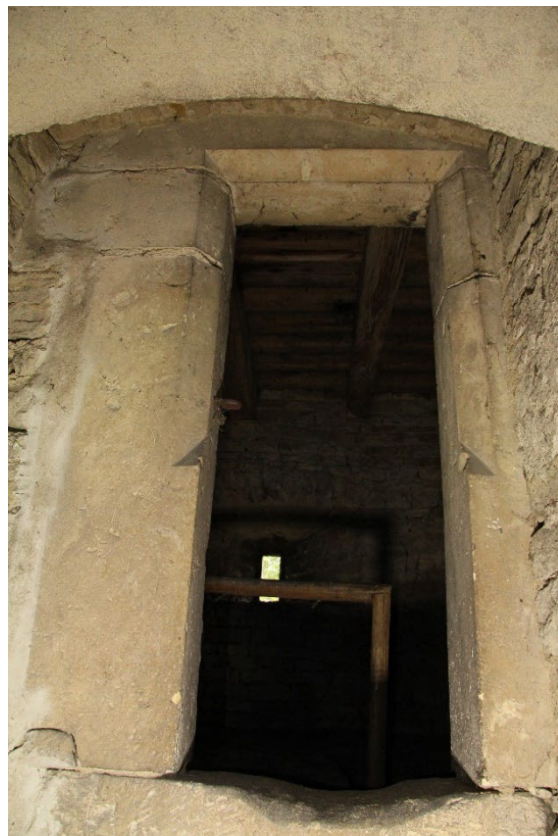
Pohled od jihu na portál vstupu do 2. patra věže. Foto: Jaroslav Skopec, 2018.
