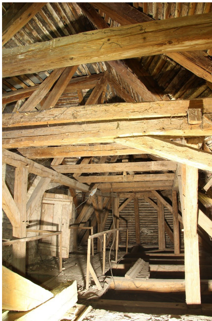
Pohled do krovu nad presbytářem od západu. Foto: Jaroslav Skopec, 2018.
