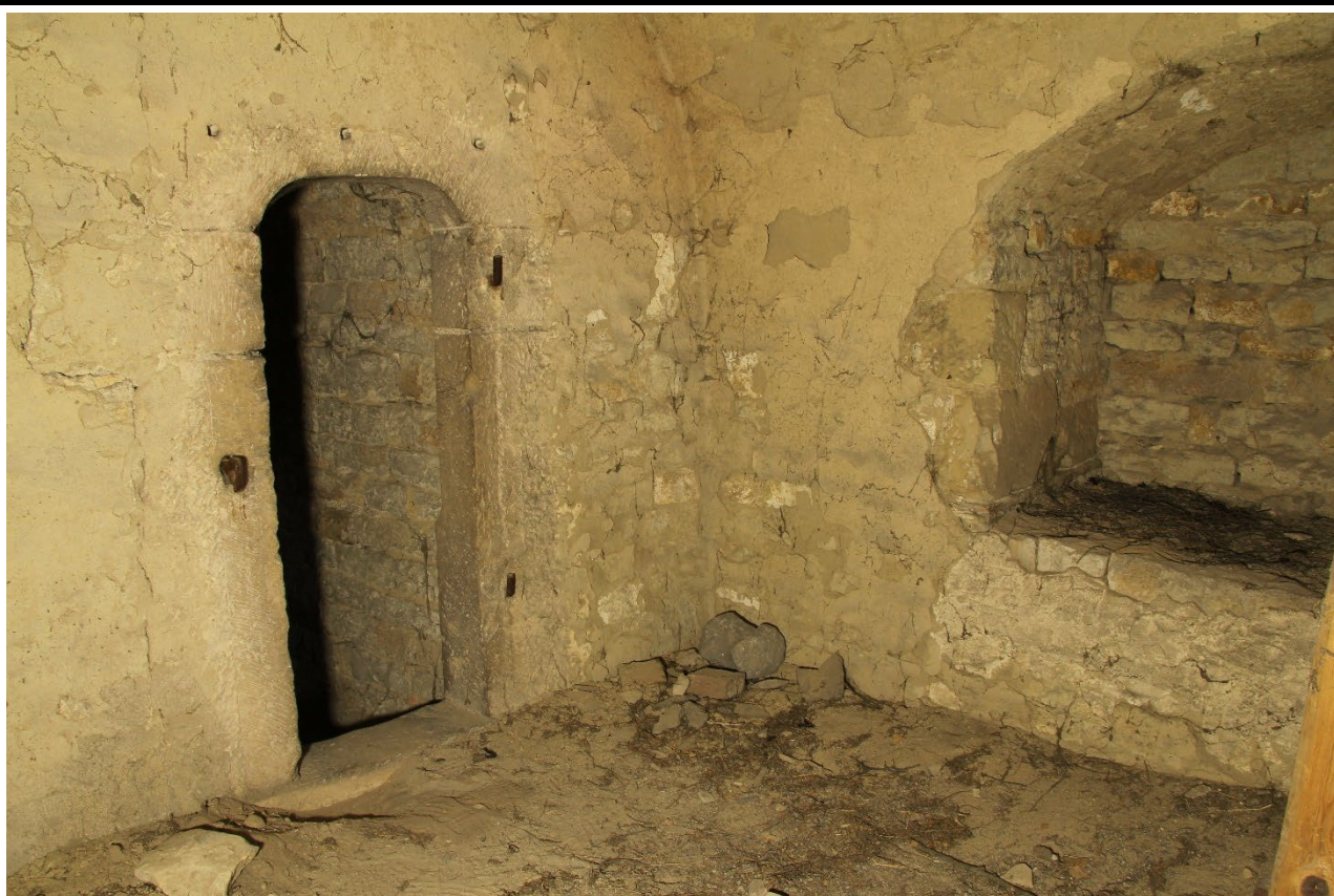
Interiér 1. patra věže v pohledu od jihozápadu. Foto: Jaroslav Skopec, 2018.
