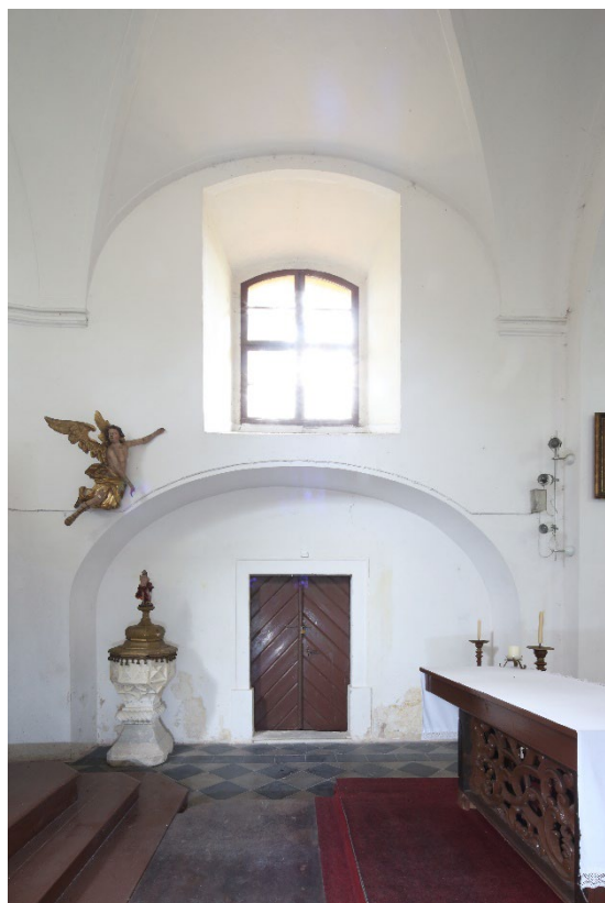
Jižní stěna presbytáře v pohledu od severu se vstupem do jižní přístavby. Foto: Marta Pavlíková, 2018.
