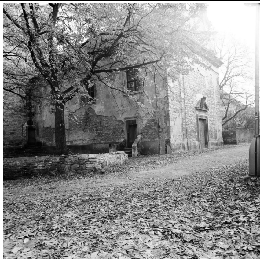
Loď v pohledu od severozápadu. Foto: 1987, sbírka negativů NPÚ ÚOP v Ústí nad Labem, sign. 95530.
