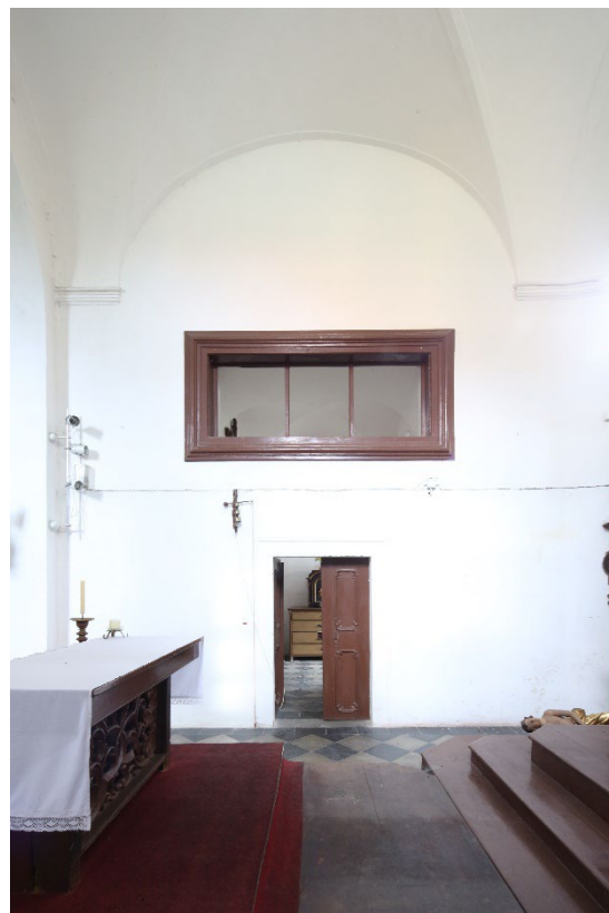
Severní stěna presbytáře v pohledu od jihu se vstupem do sakristie. Foto: Marta Pavlíková, 2018.
