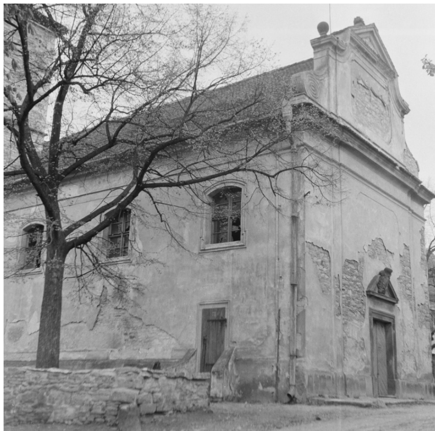
Loď v pohledu od severozápadu. Foto: 1963, sbírka negativů NPÚ ÚOP v Ústí nad Labem, sign. 8465.
