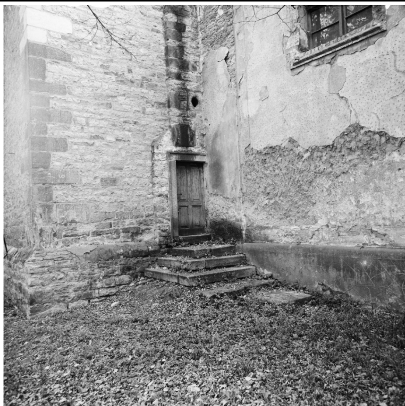
Vstup na točité schodiště věže v pohledu od severozápadu. Foto: 1987, sbírka negativů NPÚ ÚOP v Ústí nad Labem, sign. 95532.
