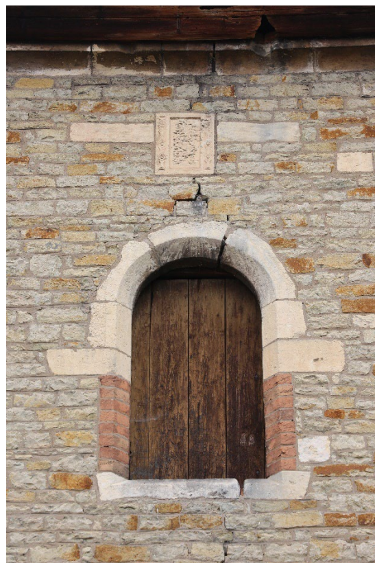
Detail zvukového okna 3. patra věže západního průčelí. Foto: Marta Pavlíková, 2018.
