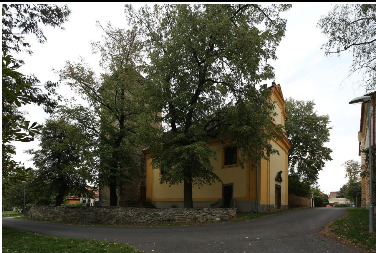
Celkový pohled od severozápadu. Foto: Marta Pavlíková, 2018.
