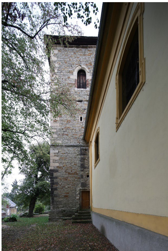
Západní průčelí věže v pohledu od západu. Foto: Marta Pavlíková, 2018.
