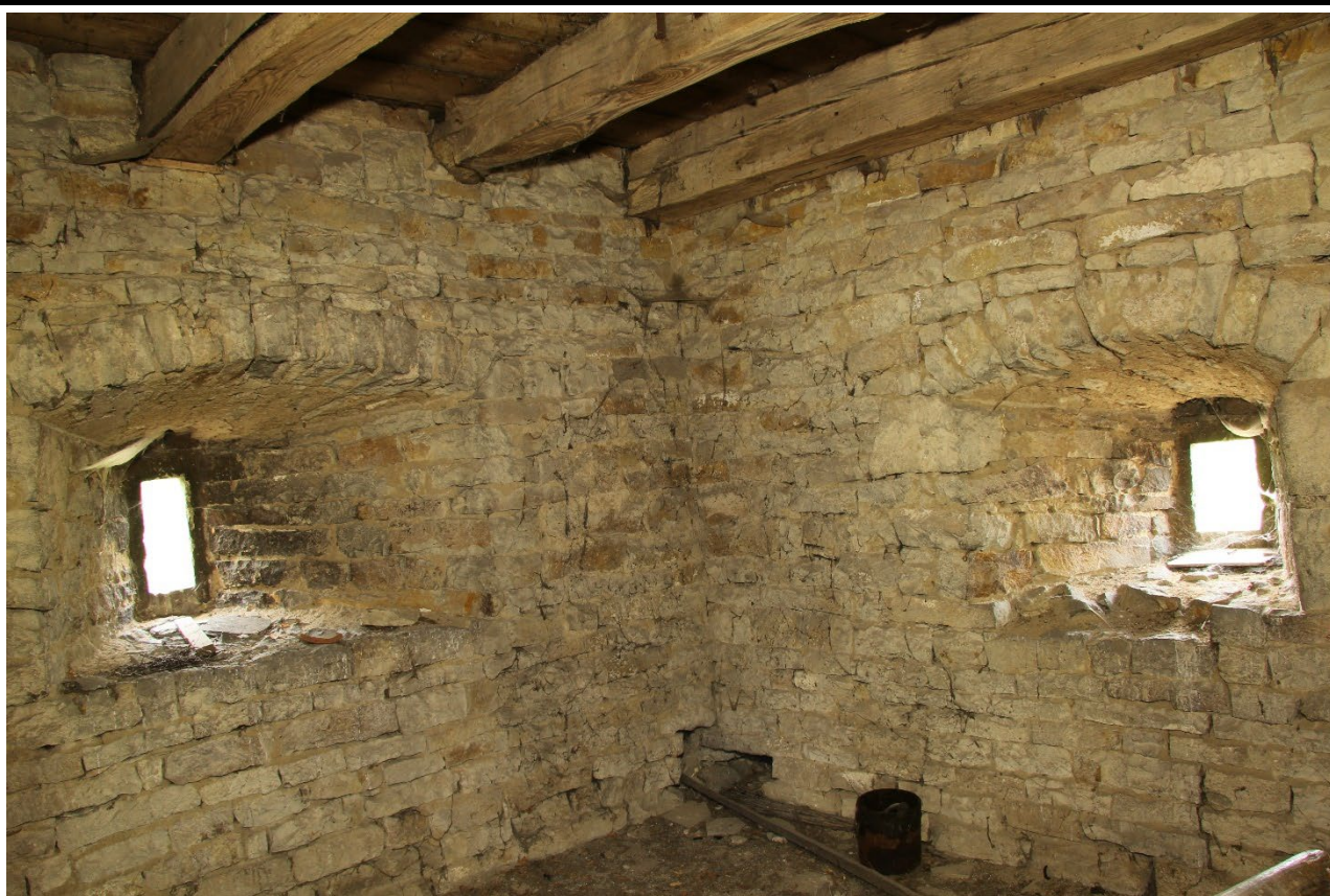
Interiér 2. patra věže v pohledu od jihozápadu. Foto: Jaroslav Skopec, 2018.
