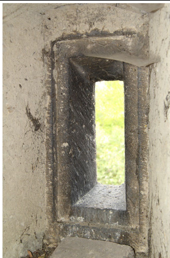
Detail ostění východního okenního otvoru 1. patra věže. Foto: Jaroslav Skopec, 2018.
