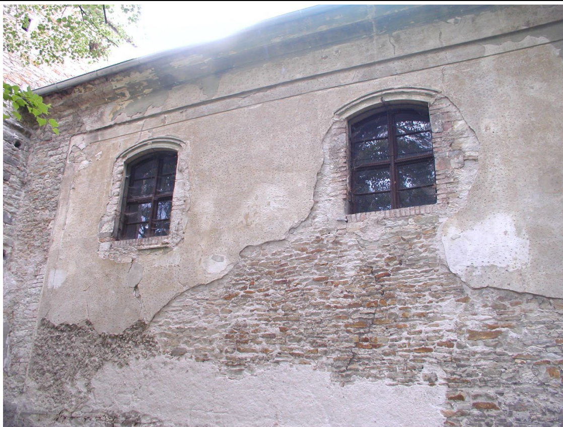
Severní průčelí lodi v pohledu od severu. Foto: Tomáš Brož, 2006.
