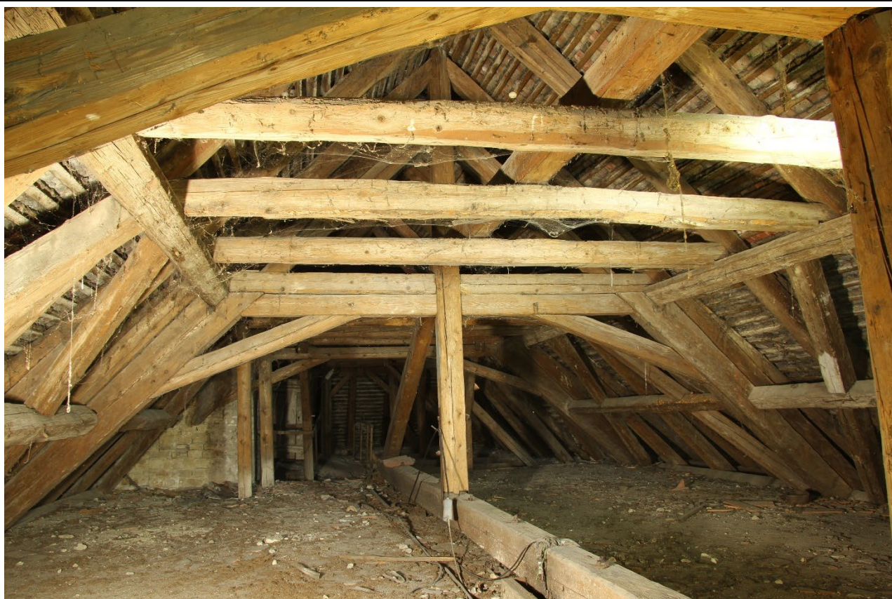
Průhled krovem nad lodí od severozápadu. Foto: Jaroslav Skopec, 2018.
