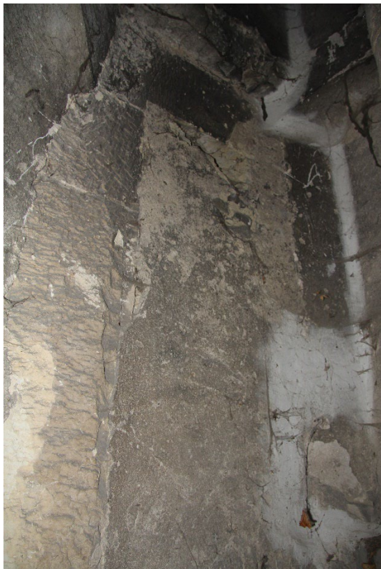
Detail portálu vedoucího z točitého schodiště do bývalého 1. patra věže. Foto: Jaroslav Skopec, 2010.
