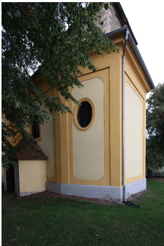
Presbytář s jižním přístavkem v pohledu od jihovýchodu. Foto: Marta Pavlíková, 2018.
