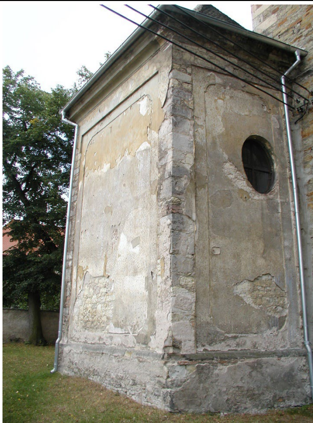
Závěr presbytáře v pohledu od severovýchodu. Foto: Tomáš Brož, 2006.
