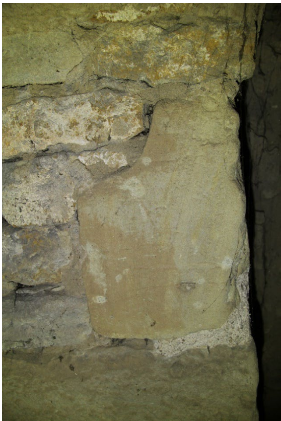
Detail druhotného prvku zazděného do východní stojky niky jižní stěny. Foto: Jaroslav Skopec, 2018.
