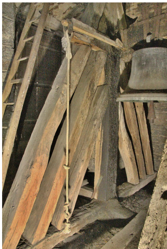
Zvonová stolice ve 3. patře věže. Foto: Jaroslav Skopec, 2018.
