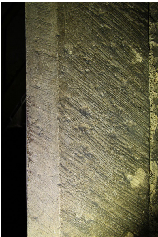
Detail opravy stojky portálu do 1. patra věže. Foto: Jaroslav Skopec, 2010.
