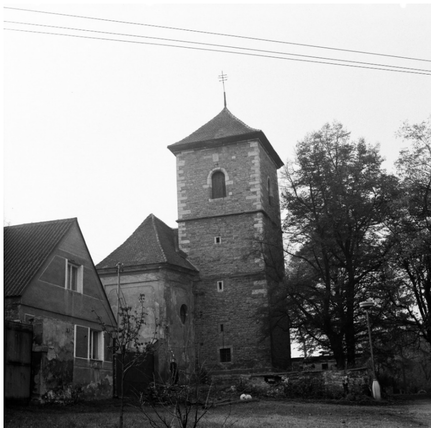
Celkový pohled od severovýchodu. Foto: 1987, sbírka negativů NPÚ ÚOP v Ústí nad Labem, sign. 95528.
