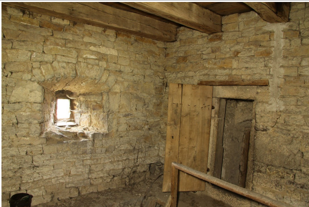
Interiér 2. patra věže v pohledu od severozápadu. Foto: Jaroslav Skopec, 2018.
